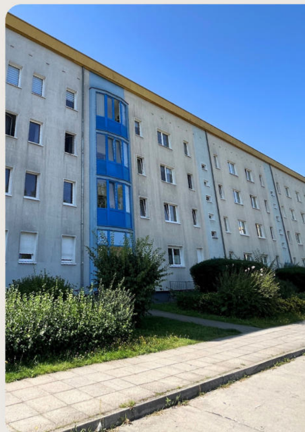
Die Fassade vor der Maßnahme
